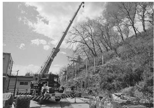
【3】 武居地区急傾斜地崩壊対策工事
