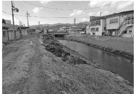
【2】 承知川河川改修工事 (承知川橋下流)
