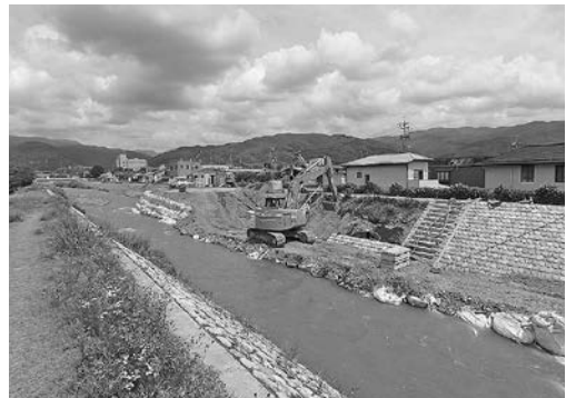
【1】 砥川河川改修工事 (赤砂橋上流左岸)
